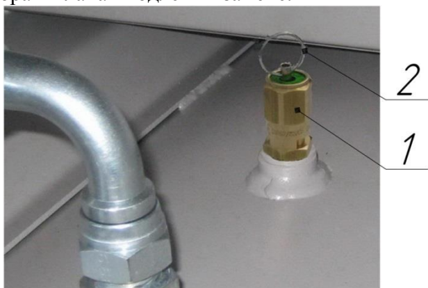
Рисунок 10 – Клапан предохранительный пружинного типа
